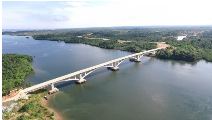
Gambar 2.4 Jembatan Pulau Balang
